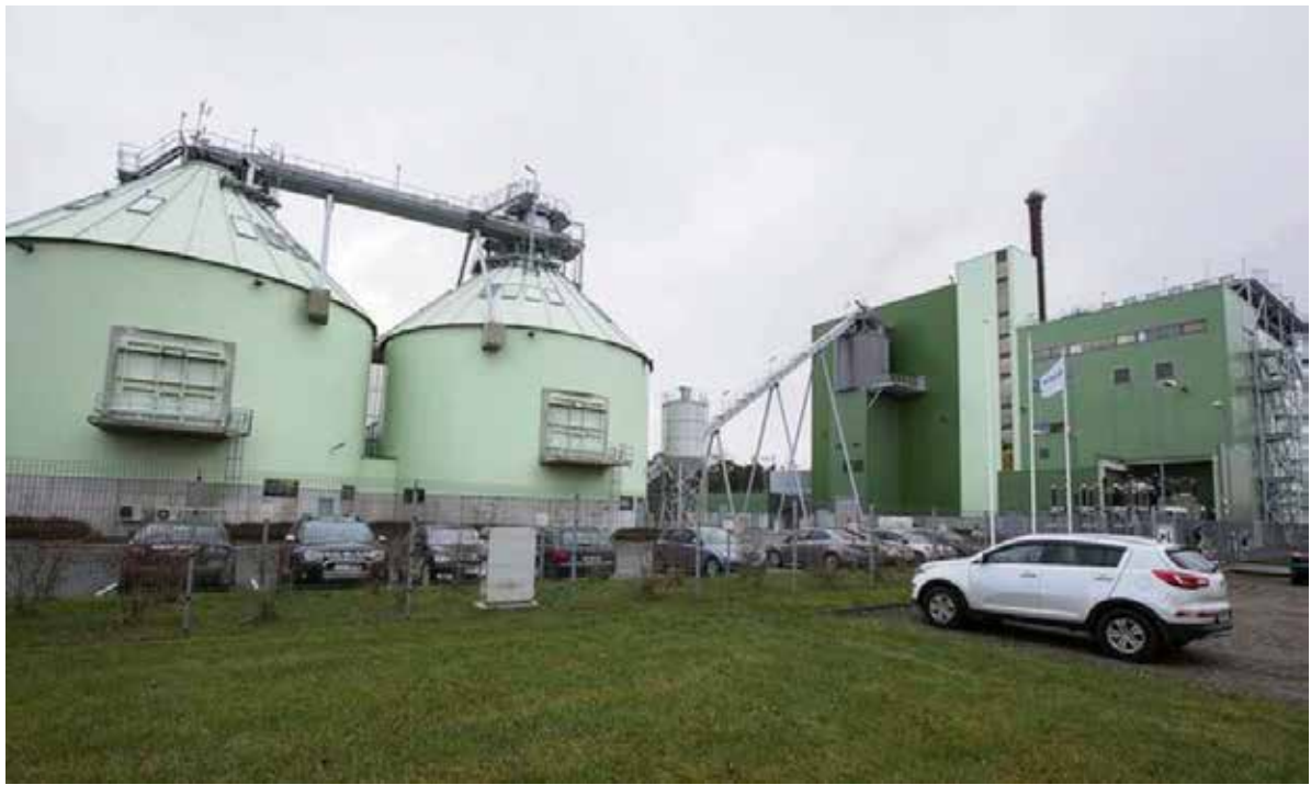
Picture 2. Pärnu CHP plant. B
