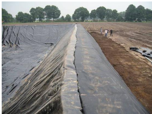
2. att. Lagūnas tipa šķidrmēsļu krātuve
